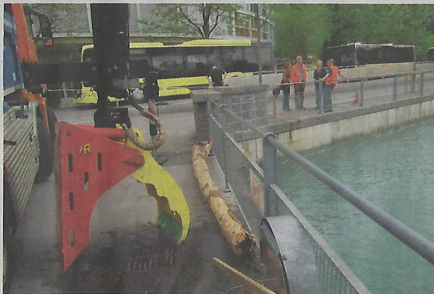
Der Entlastungsstollen beim Thunersee kann Hochwasserschäden vermeiden.
